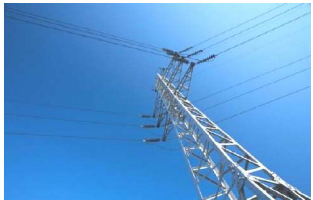
Рисунок 5.5 – Угловая опора 220 кВ
