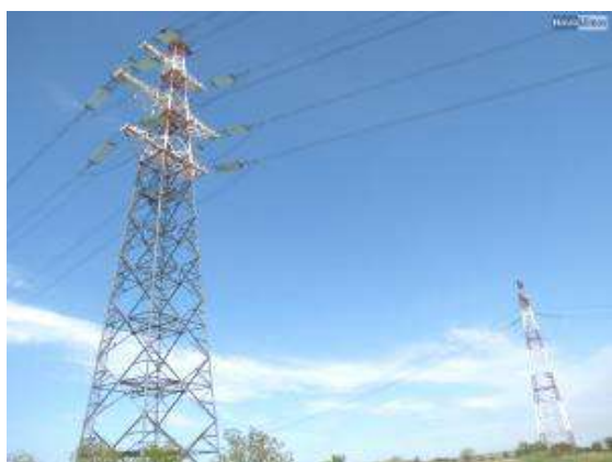
Береговая переходная опора 330 кВ
