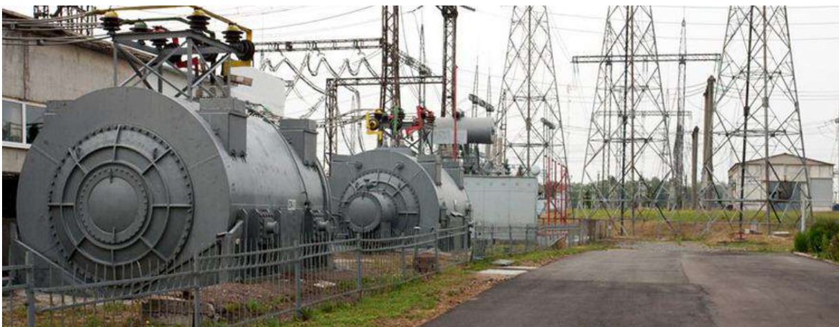
Рисунок 9.1 – Синхронные компенсаторы, установленные на ОРУ подстанции
