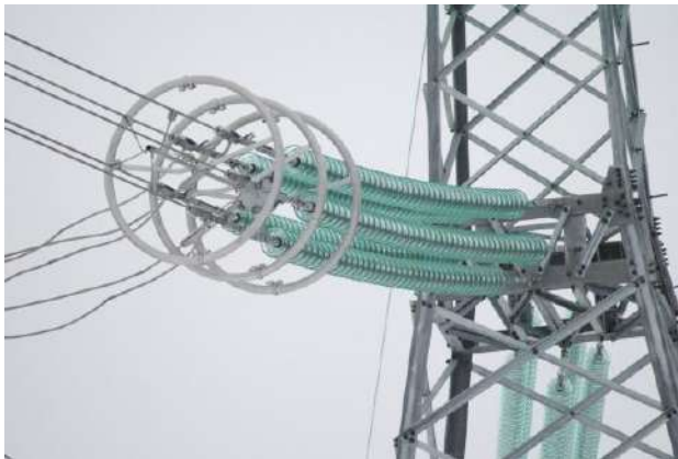
Рисунок 5.28 – Гирлянды изоляторов ВЛЭП
