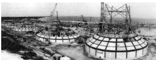
Наплавные фундаменты опор 330 кВ
