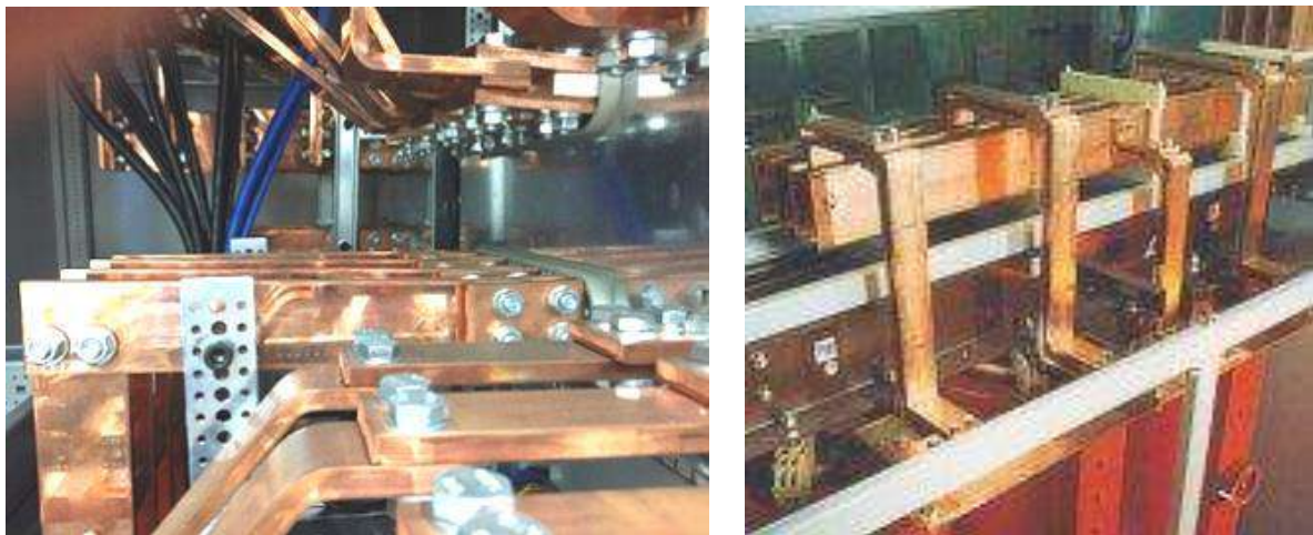
Рисунок 7.18 – Открытый шинопровод
