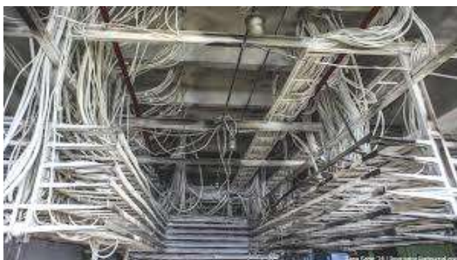
Рисунок 6.13 – Прокладка кабеля по кабельному полуэтажу
