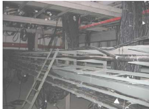
Рисунок 6.13 – Прокладка кабеля по кабельному полуэтажу
