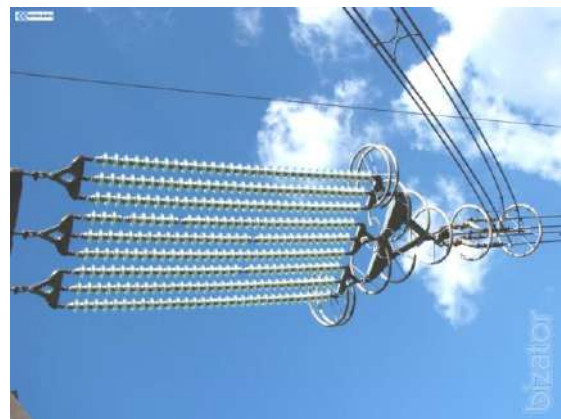
Рисунок 5.28 – Гирлянды изоляторов ВЛЭП
