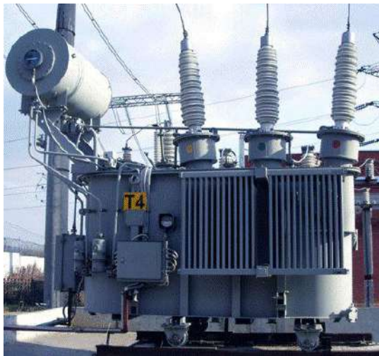
Рисунок 10.5 – Силовой трансформатор с масляным охлаждением мощностью 1000—6300 кВА напряжением 35 кВ:
