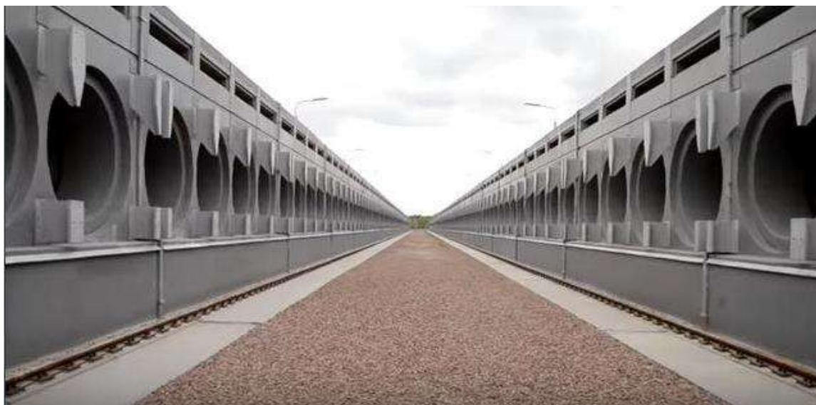
Рисунок 4.13 – Хранилище ОЯТ по технологии сухого модульного хранения (ХОЯТ-2) на территории ЧАЭС
