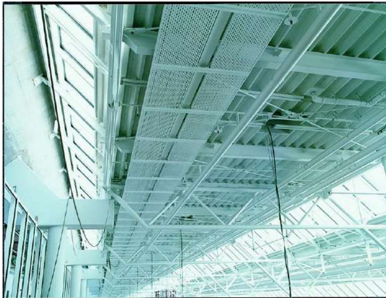
Рисунок 6.14 – Открыто проложенные кабели на лотках
