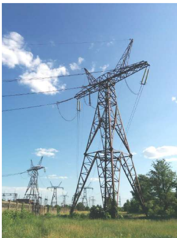
Рисунок 5.7 – Анкерные угловые опоры а – одностоечная 330 кВ; б – двухстоечная 110 кВ
