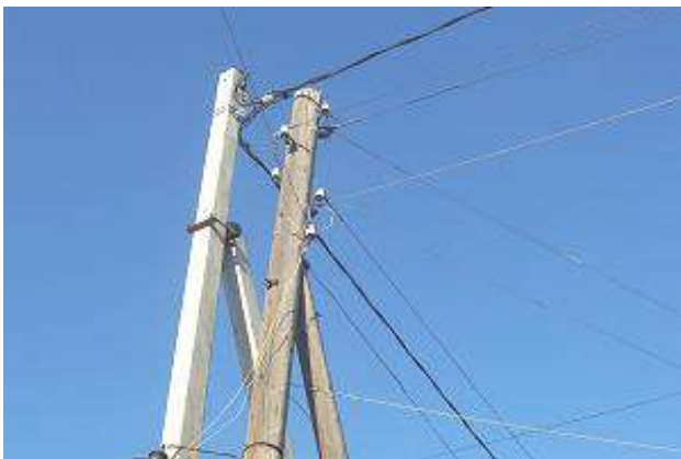
Рисунок 5.4 – Угловая опора 0,4 кВ
