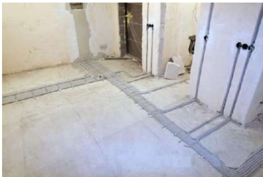
Рисунок 6.12 – Прокладка кабелей в двойном полу
