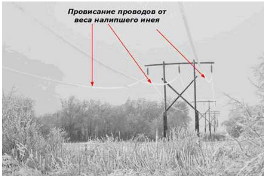
Рисунок 5.12 – Провисание проводов от веса налипшего снега и инея
