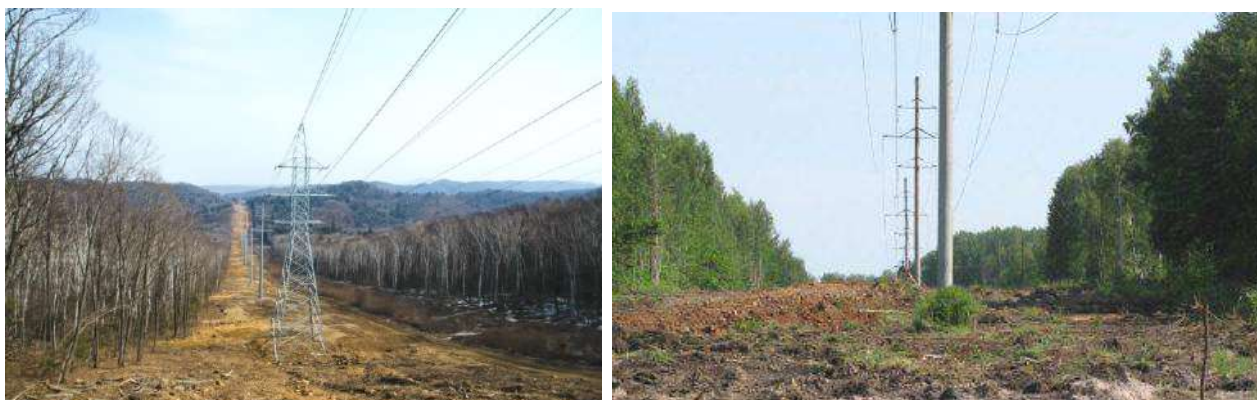
Рисунок 5.20 – Просеки для ВЛЭП
