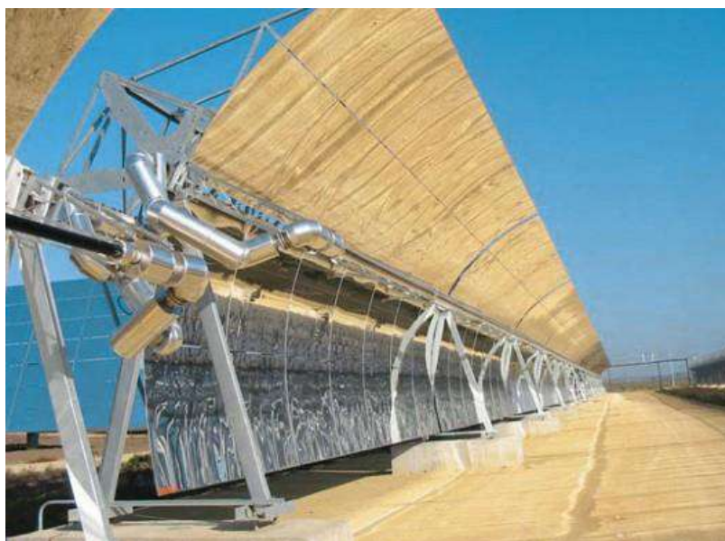
Рисунок 4.30 – Длинные параболические (в поперечном сечении) зеркала-пленки с трубами для разогрева теплоносителя (фото Solucar)
