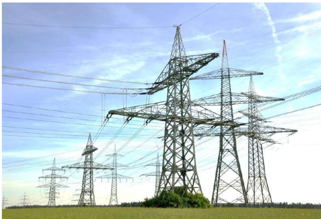
Рисунок 5.6 – Угловая опора ВЛЭП 500 кВ
