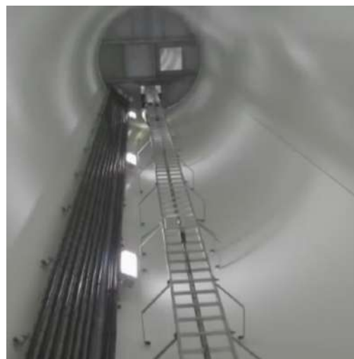
Рисунок 4.19 – Схема компоновки цилиндрической башни ВЭУ (вид внутри)
