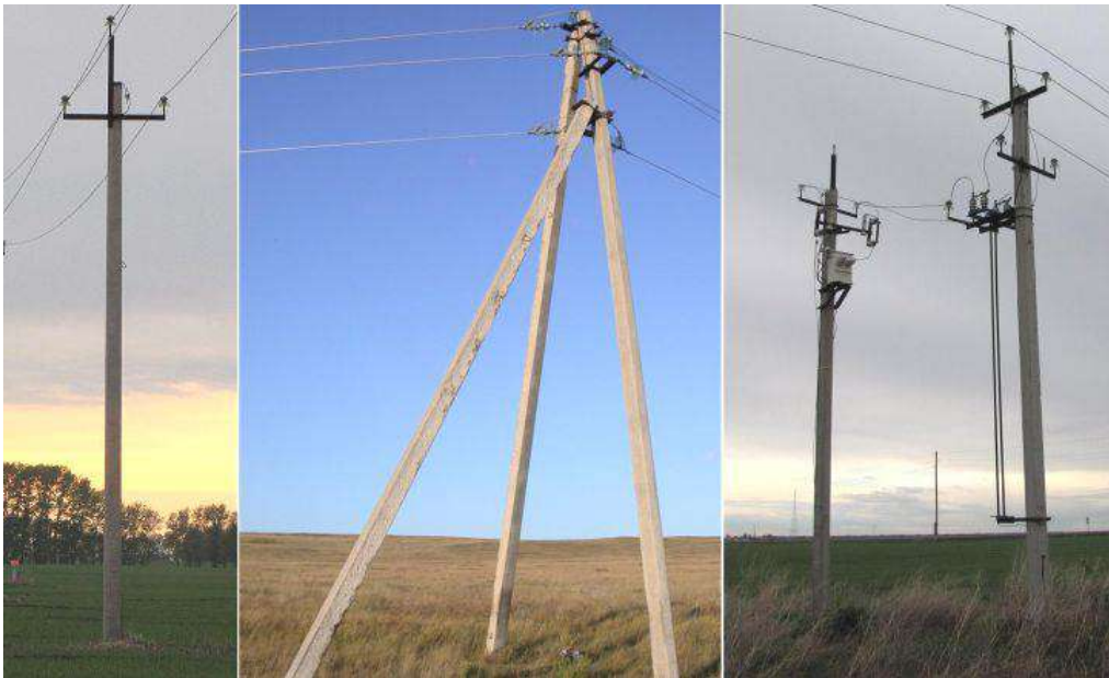
Рисунок 5.15 – Формы железобетонных опор ВЛЭП
