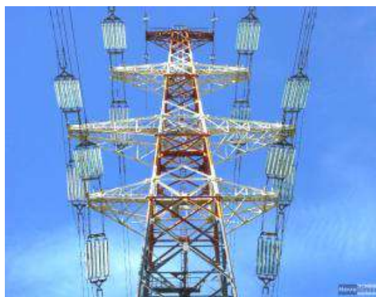
Верхушка переходной опоры 330кВ
